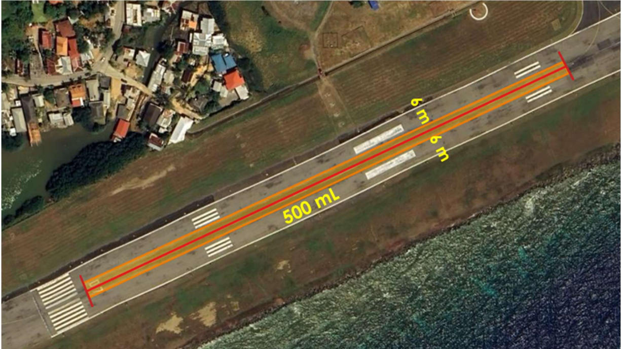
Sección 1: Remoción de Caucho en Pista 07 del Aeropuerto Internacional Juan Manuel Gálvez
